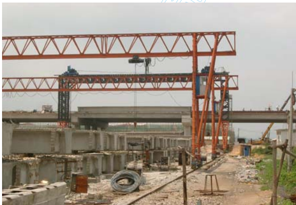
T 梁预制、跨墩龙门吊喂梁示意图
