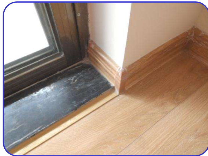
木地板踢脚线使用成品接口盖，效果美观 云浮项目
