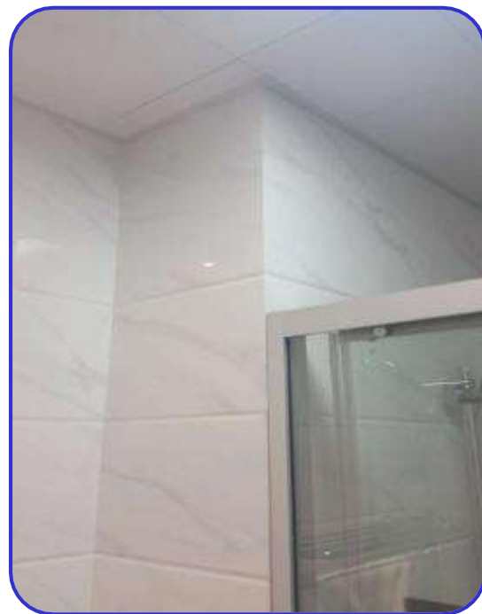
墙砖缝隙大小一致，海棠角拼接美观 河南新乡凤凰湾
