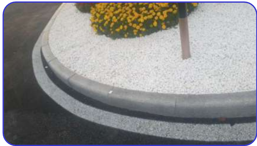
弧形路沿石拼接圆顺，缝隙大小一致 河南新乡凤凰湾
