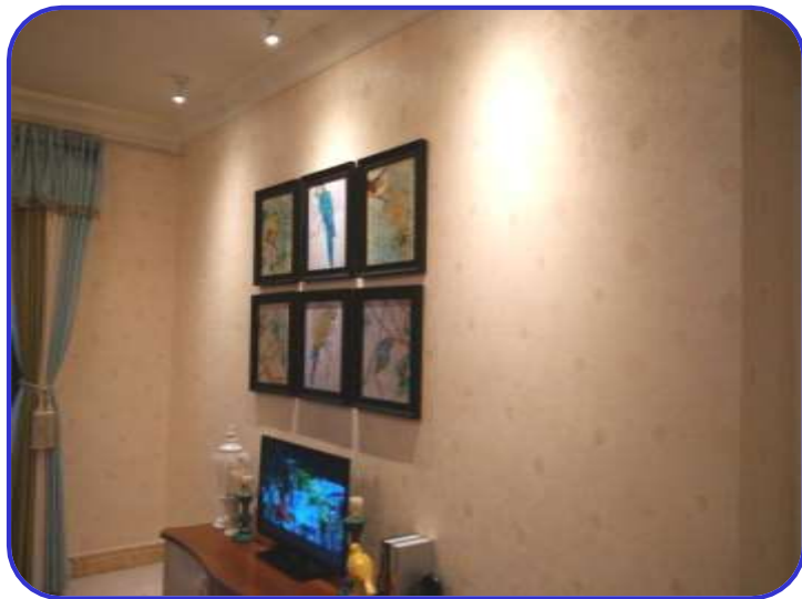
墙纸铺贴平整，纹理拼接吻合 河南新乡凤凰湾
