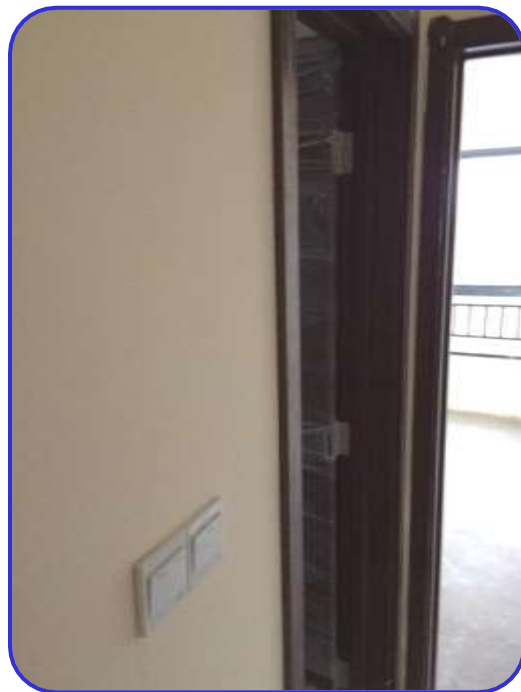
门套与墙身接缝严密，无需打胶处理 如东项目
