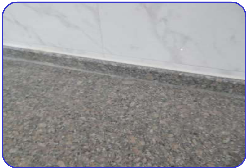
厨房台面石周边打胶圆顺、美观 云浮项目
