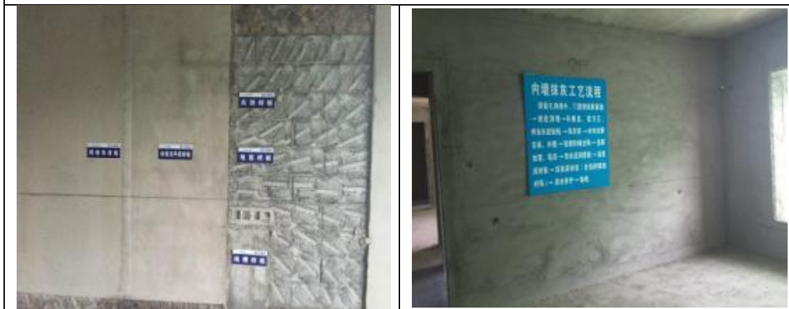
展示抹灰灰饼制作、甩浆、找平、挂网、线槽暗埋等效果
