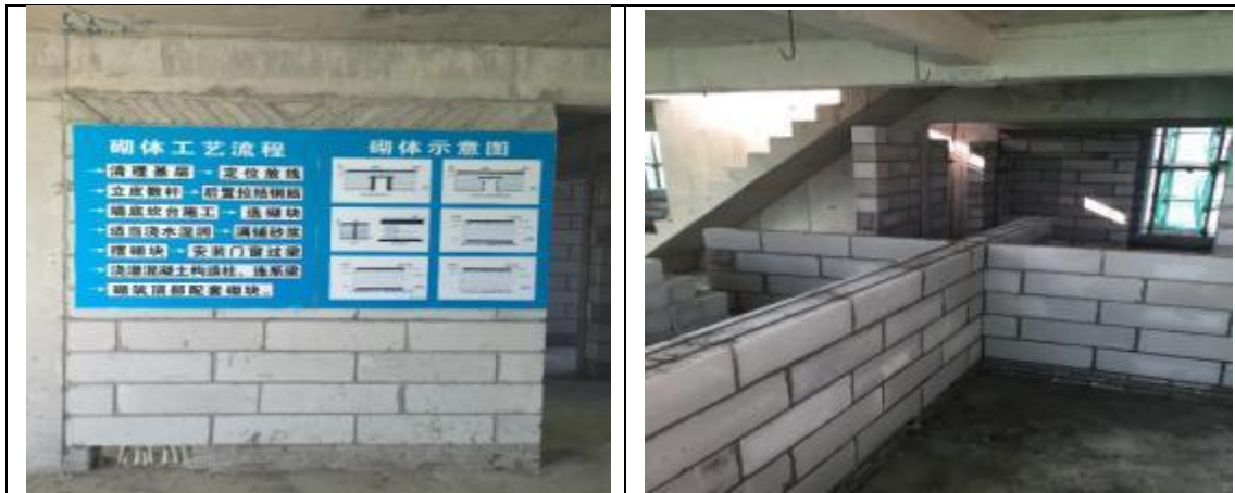
展示砌筑过程，展现过程中灰缝饱满、拉结筋设置等
