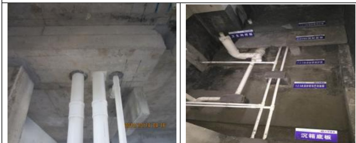
展示卫生间沉箱从底板至盖板的各工序及预埋管线情况
