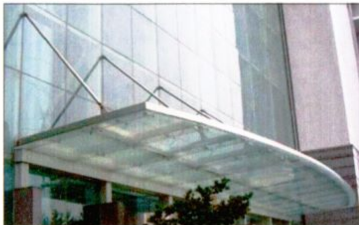
钢雨篷五(玻璃在结构下)
